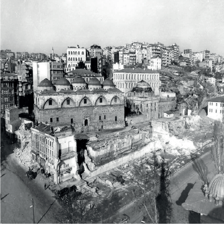
Fotoğraf 4. İstanbul'da yol açmak hedefiyle Tophane Kışlası'nın yıkımı
