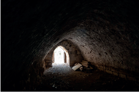
Şeyh Muhammed Zarrar Camii Bodrum Ön Mekân
